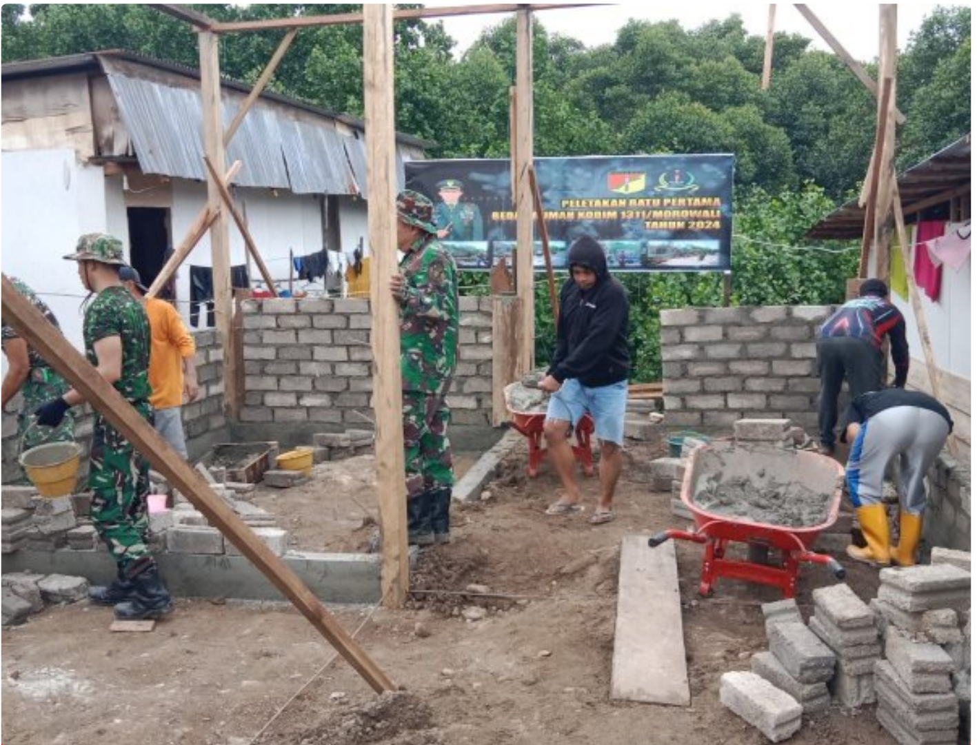
Tampak pengerjaan bedah rumah tahap pemasangan Batako
