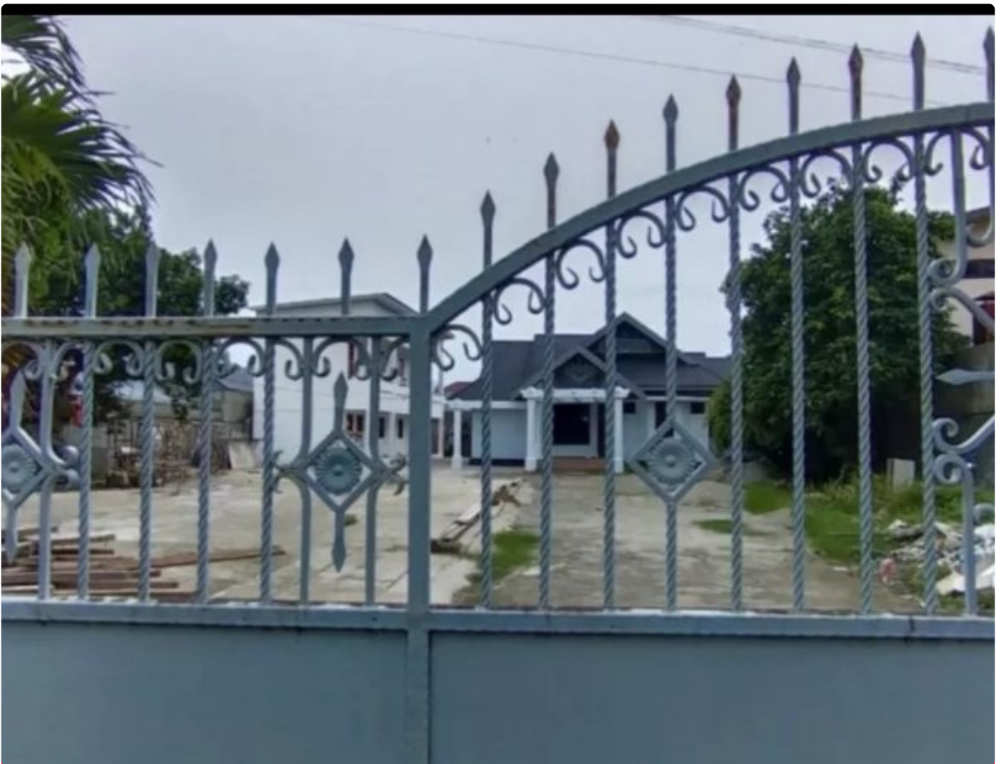
Mess Pemda Morowali di jln Garuda Palu
